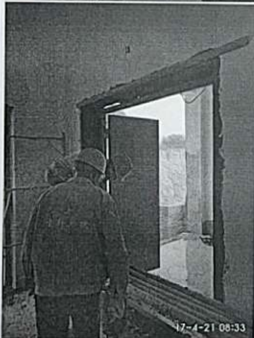
配电室防火门安装
