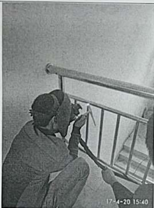
配电室楼梯扶手安装
