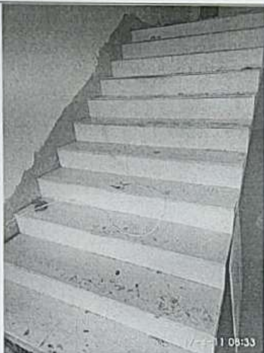
配电室楼梯贴地板砖
