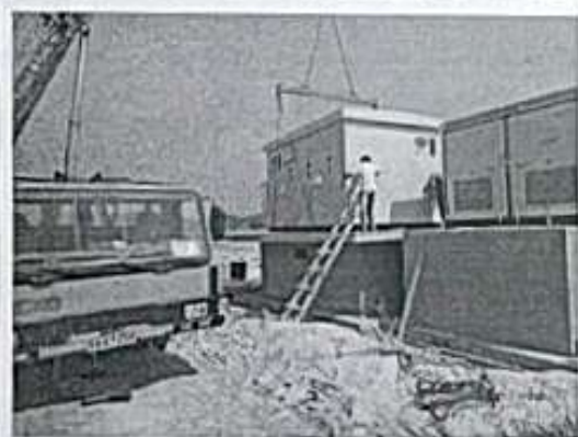
逆变器、箱式变压器进场安装
