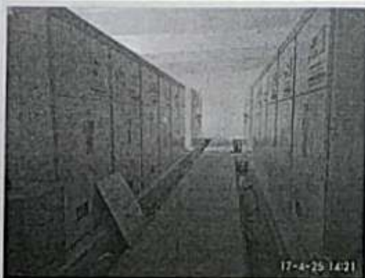
配电室接地变、开关柜等设备安装
