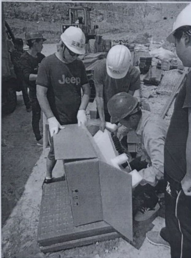
汇流箱开箱检 查
