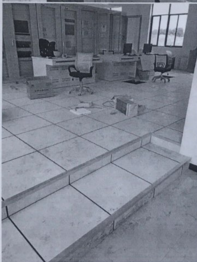
配电室二层静 电地板安装
