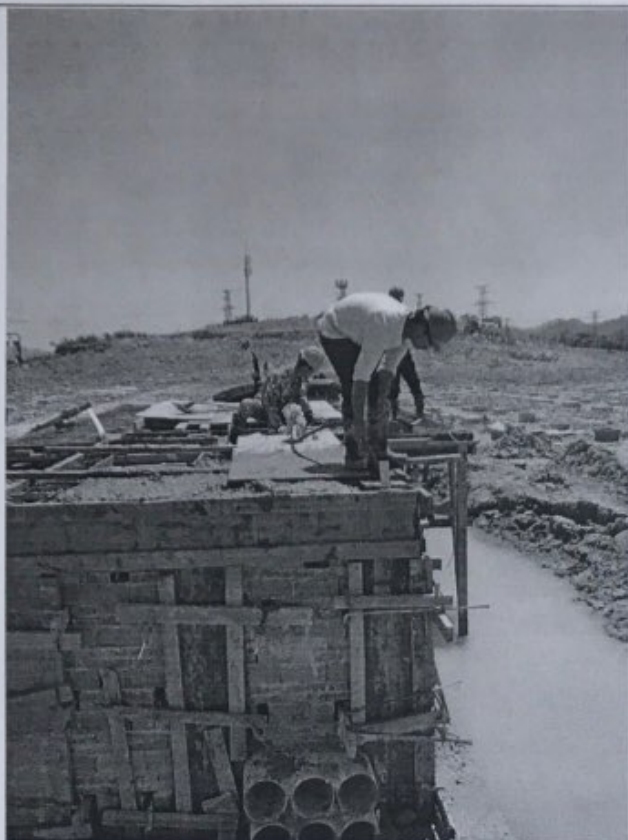
箱逆变基础顶 板、梁及柱浇筑
