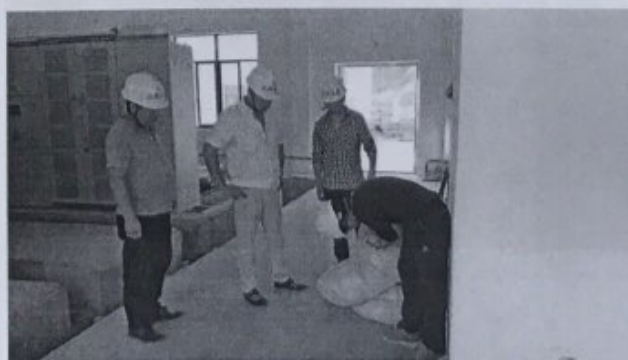
现场检查电缆 规格、厂家
