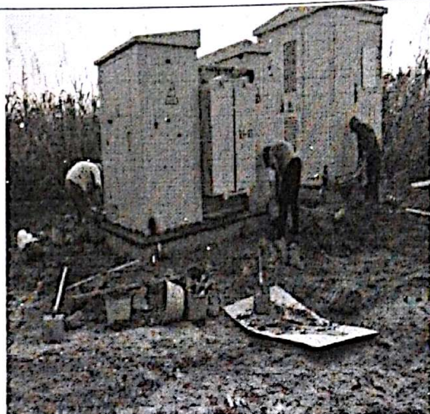
箱变散水坡施工
