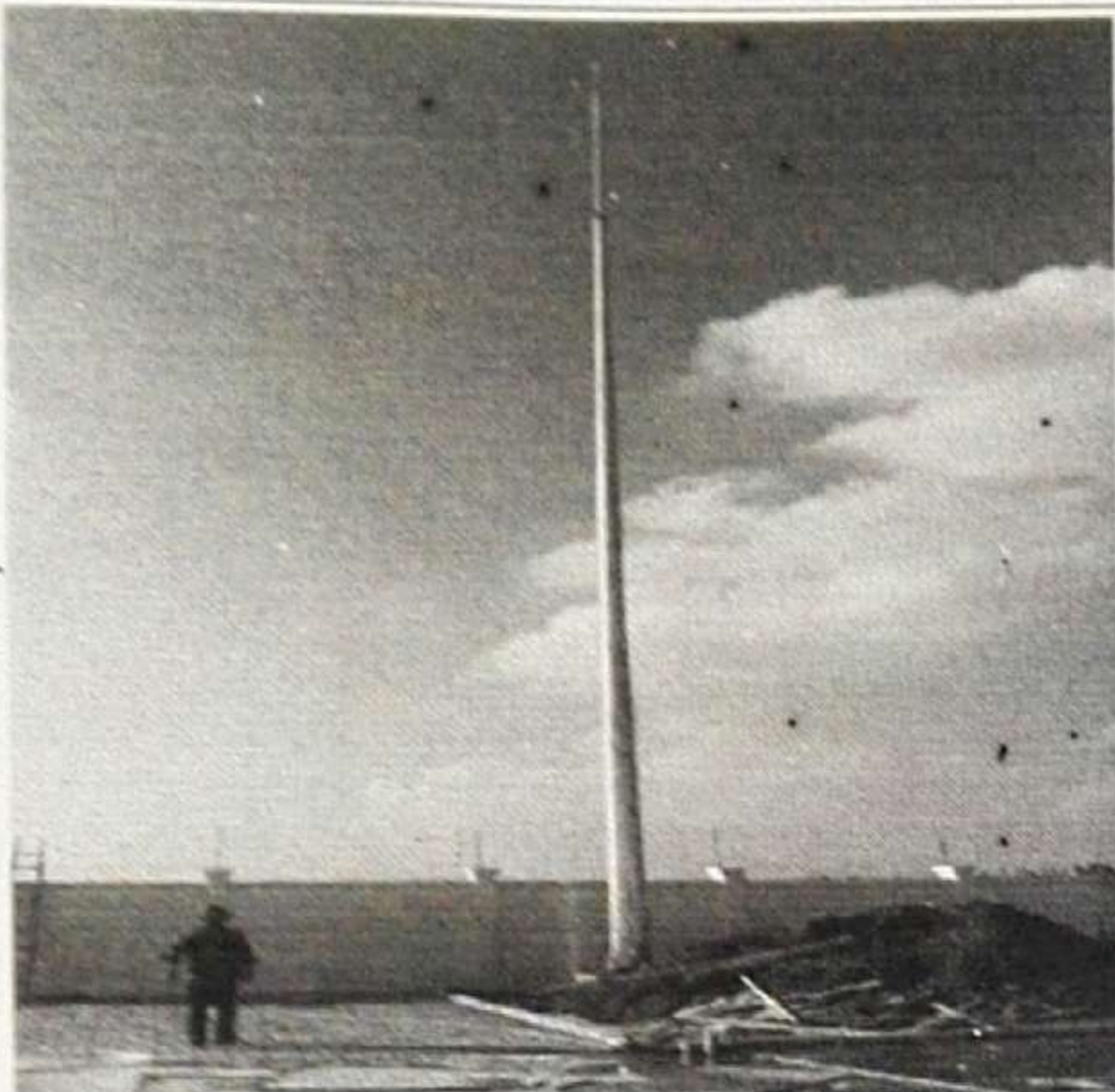
避雷针安装完成
