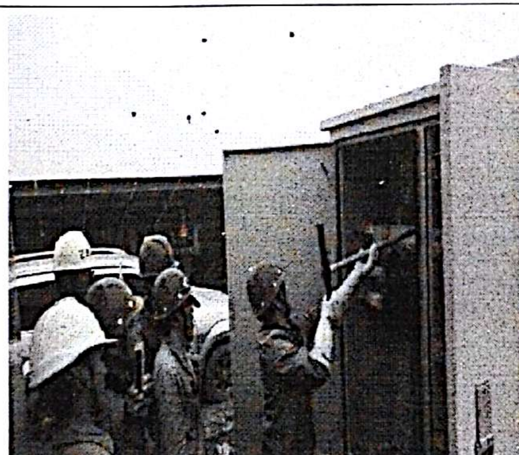
箱式变压器送电
