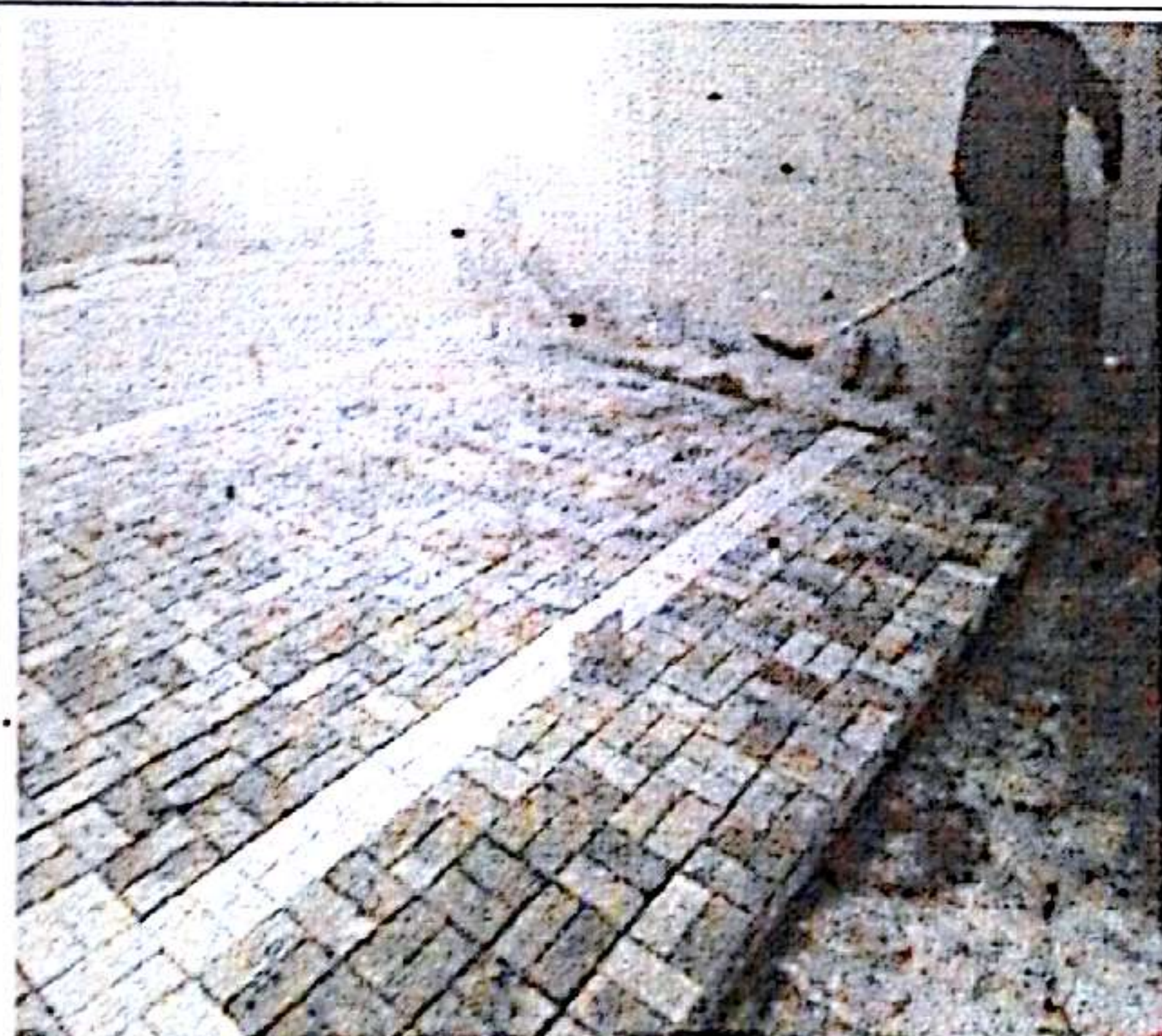
升压站室外地砖施工
