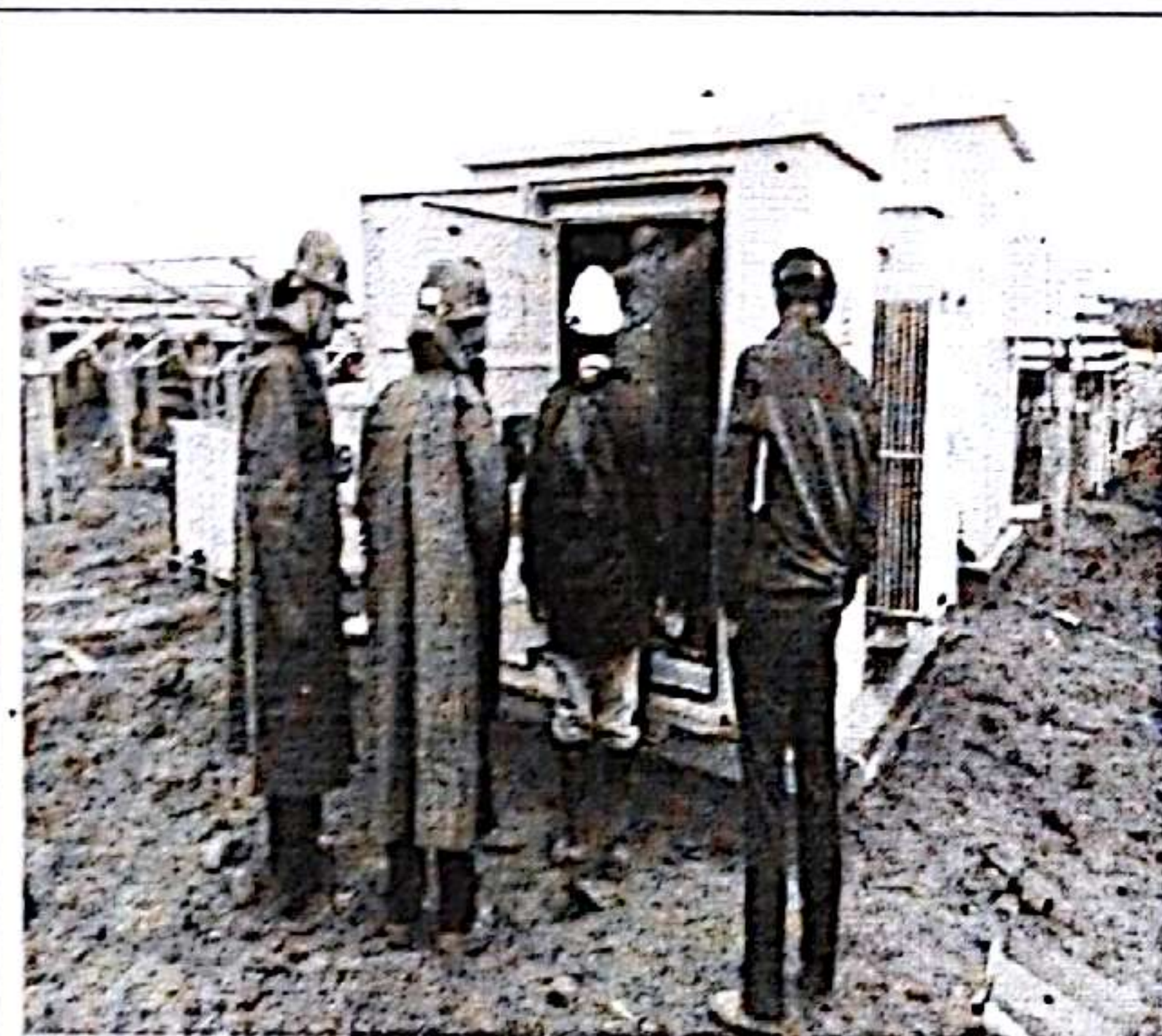
箱逆变检查、消缺
