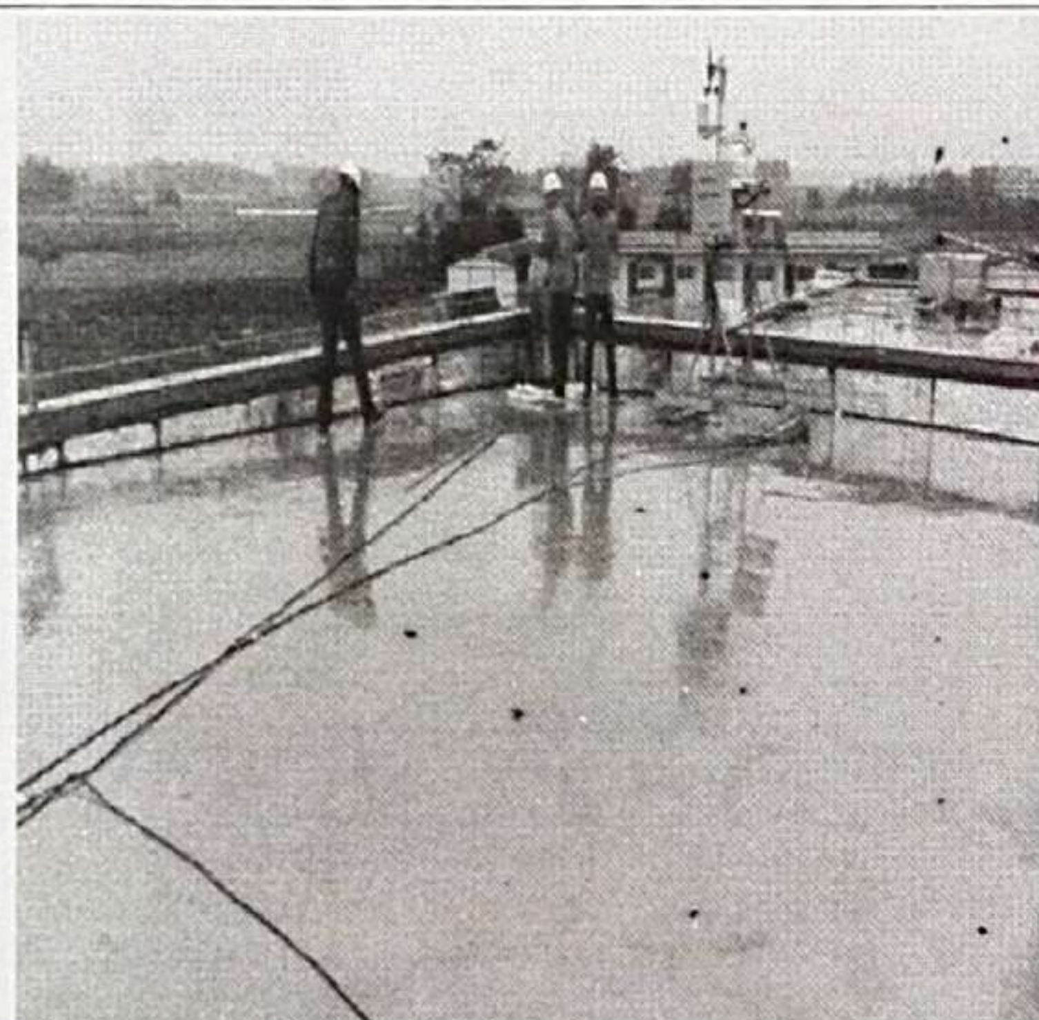
配电楼防雷接地接闪器焊接质量检查
