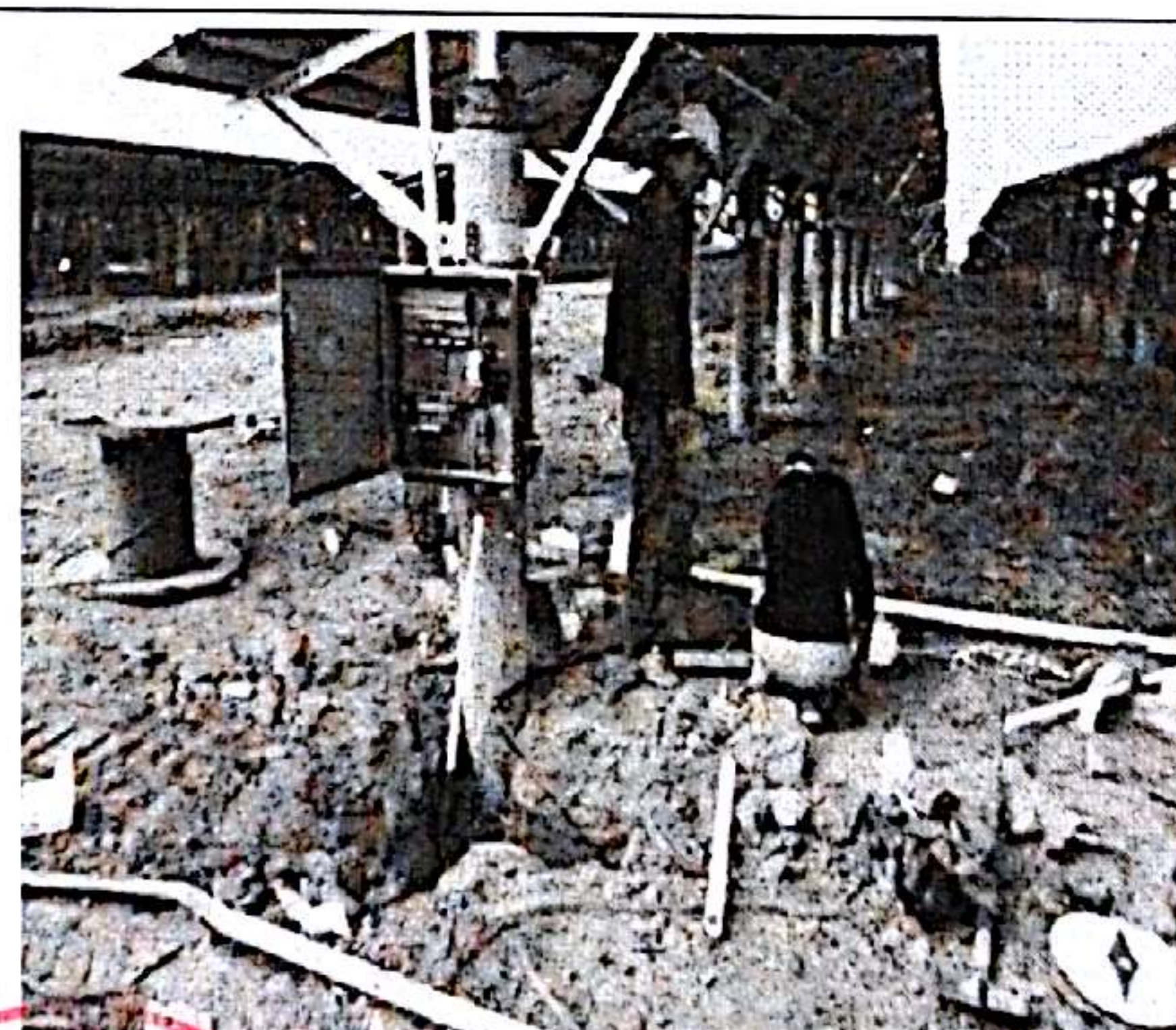
汇流箱接线 2*70 电缆接线
