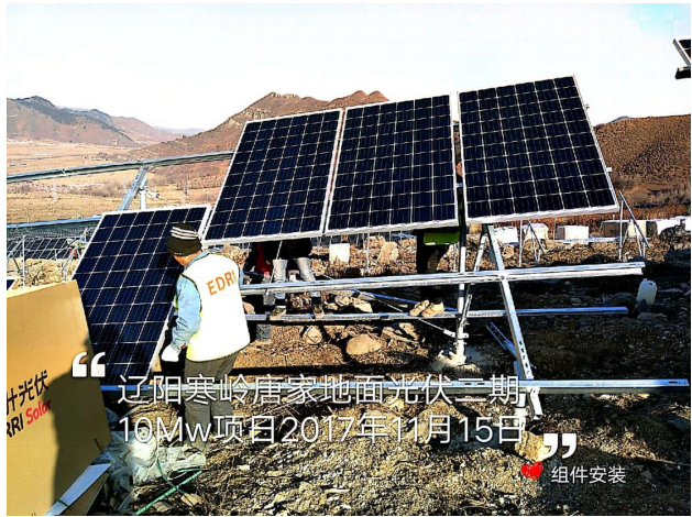
光伏区组件、支 架安装
