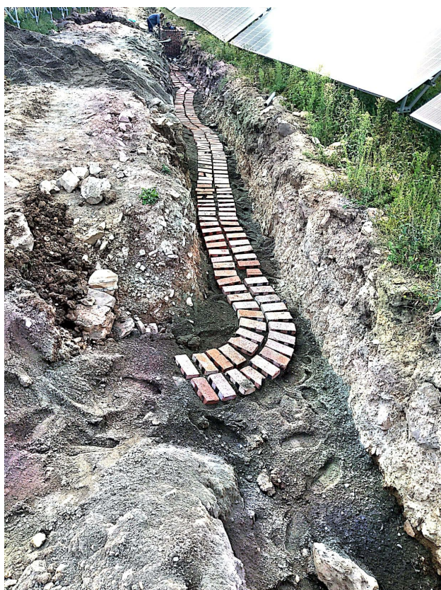
电缆沟铺砂盖 砖
