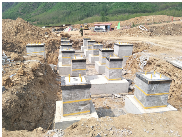
刀闸、互感器等 设备基础浇筑 完成
