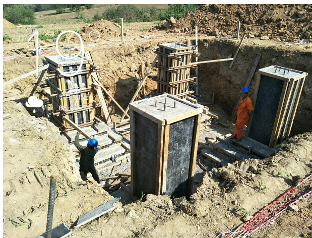
分歧塔基础浇 筑完成
