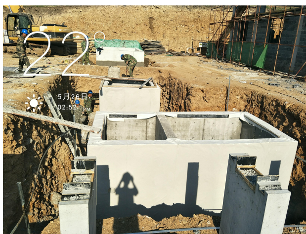
事故油池、电缆 井、箱变、主变 浇筑完成
