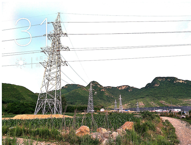
外线施工完成
