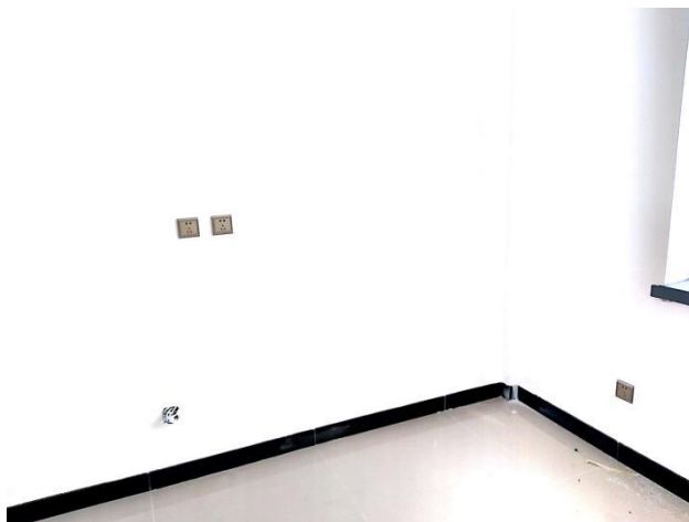
综合楼内部装 修完成
