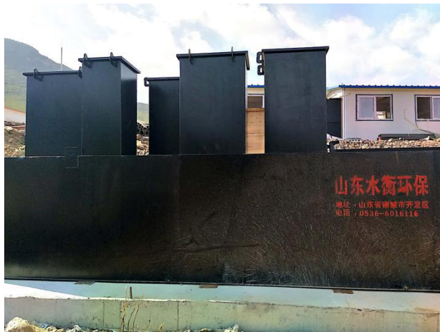
污水池安装中
