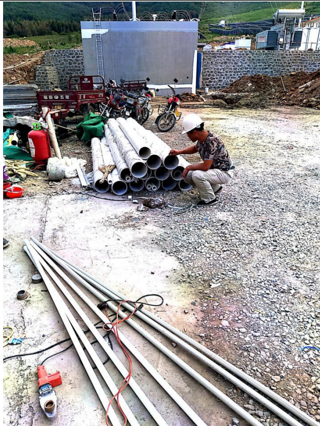
监理检查给排 水管
