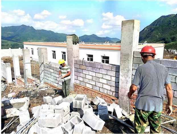
管理区挡墙砌 砖
