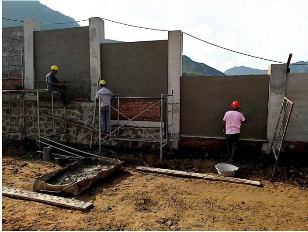
管理区挡墙抹 灰
