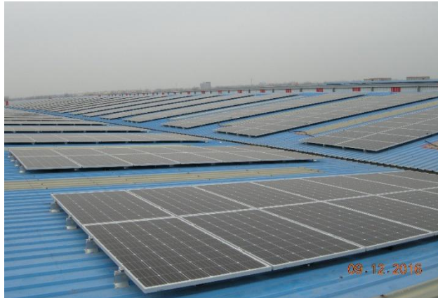
安 装 组 件 及 调 整 完 成。
