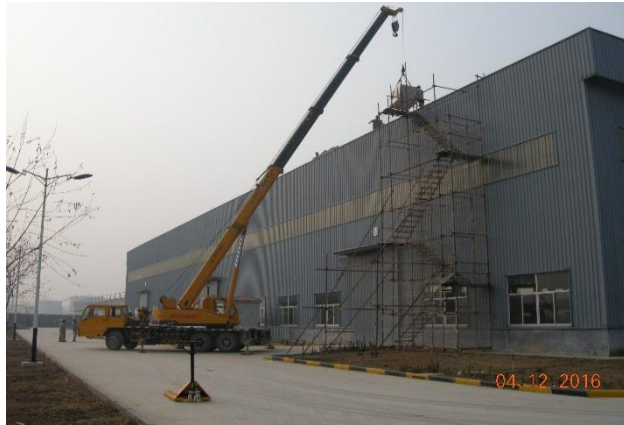
组件往彩钢厂 房上吊装。
