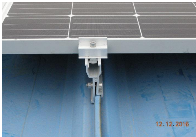
组件安装检查。
