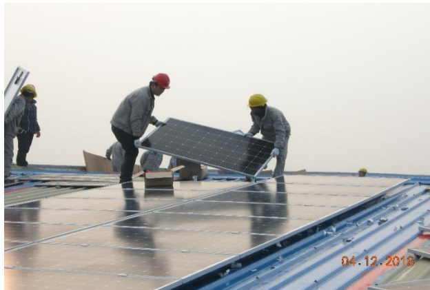
安装组件现场。
