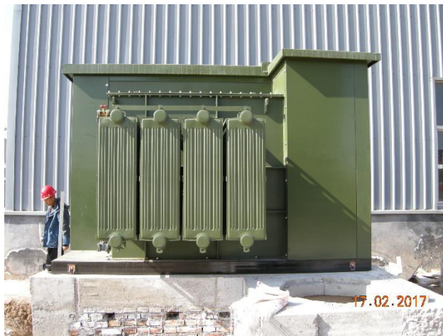
美凯华：箱变安装在基础上。
