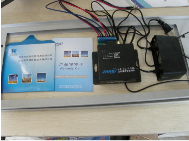
开关站安装通讯设备。
