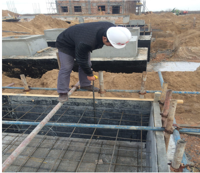
P2 主变基础钢筋模板验收 2
