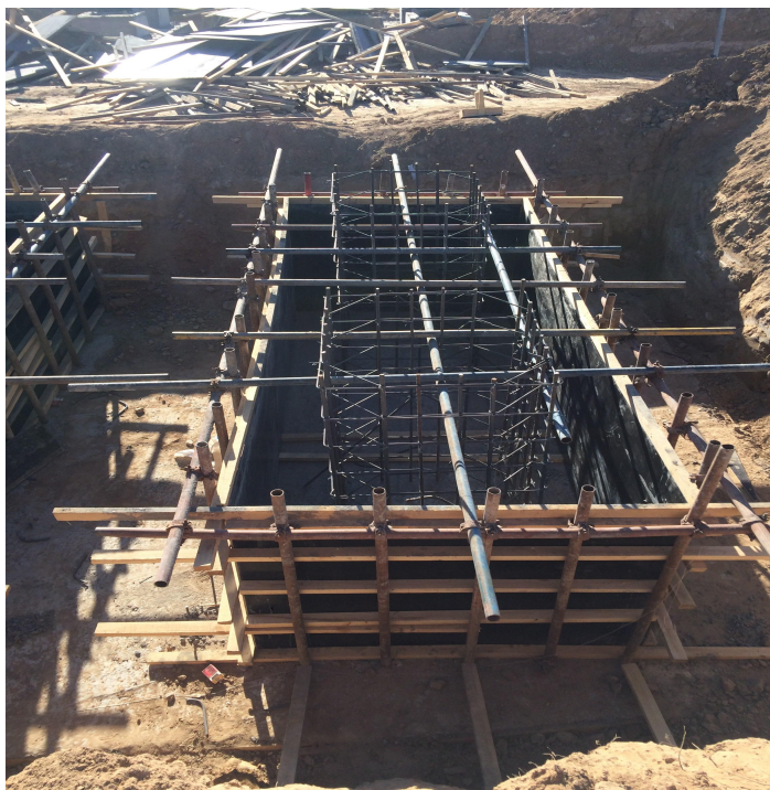
P2 户外构架基础钢筋模板验收
