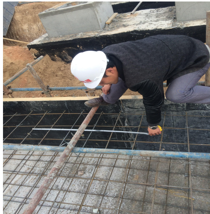
P2 主变基础钢筋模板验收 2
