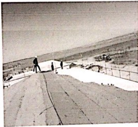
综合楼屋面保温施工
