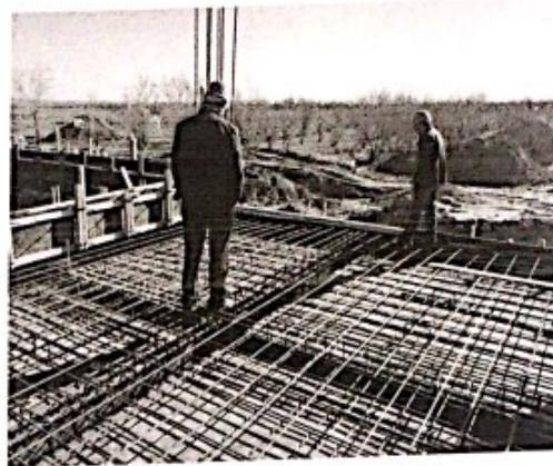
消防水泵房钢筋绑扎，砼浇筑准备
