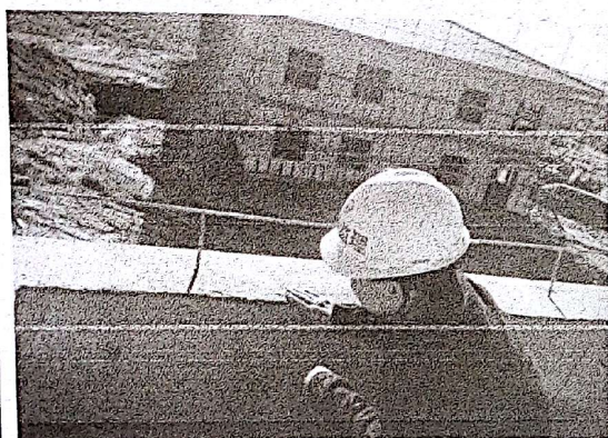
20170525__p2 电气楼屋面女儿墙检查 防雷接地
