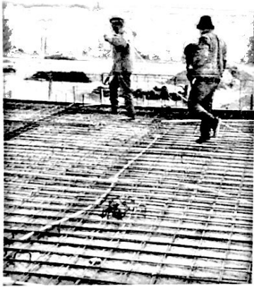
2017. 3. 11 在 p2 区电气楼房顶巡视检查钢筋
