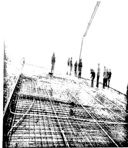
2017.3.15 日下午监理和质检部在 p2 区升压站电气房屋面浇筑砼
