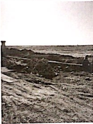
围墙墙体砌筑
