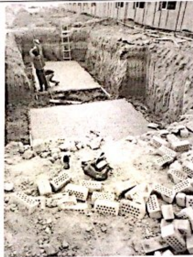
化粪池、污水池垫层浇筑
