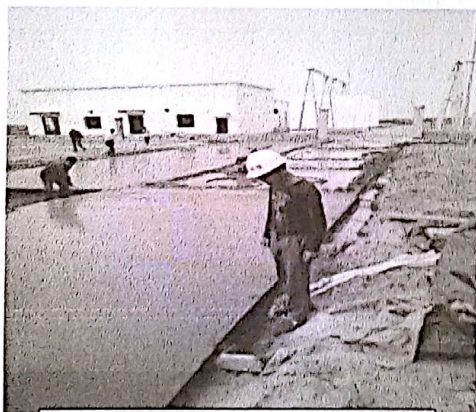
2017.6.15 在 p3 管理区浇筑道路
