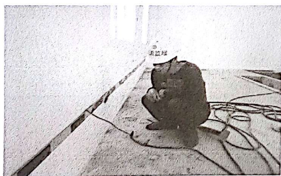
2017.6.7 日在 p3 升压站检查二次等电位接地焊接
