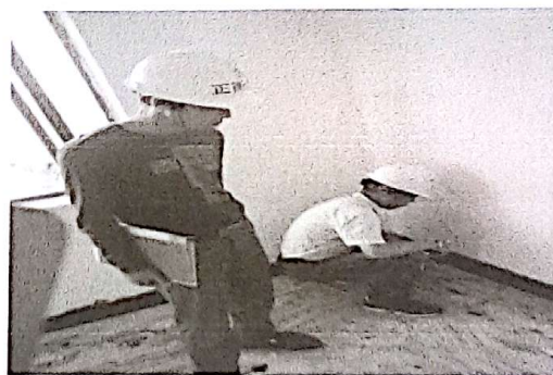
2017.6.15 在 p3 综合楼二层和质检部检查粘砖
