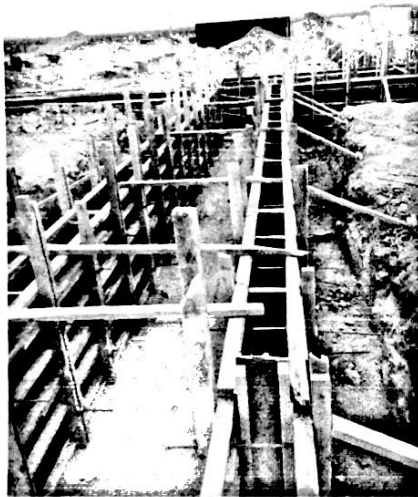
2017. 3. 10 在 p3 巡视检查电缆沟模板
