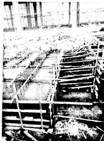
p4 区主变基础混凝土施工
