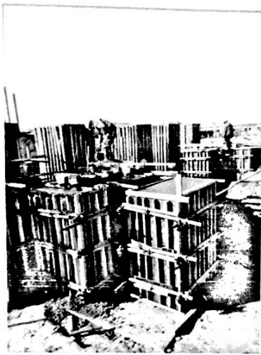
p4 区 svg 基础混凝土施工
