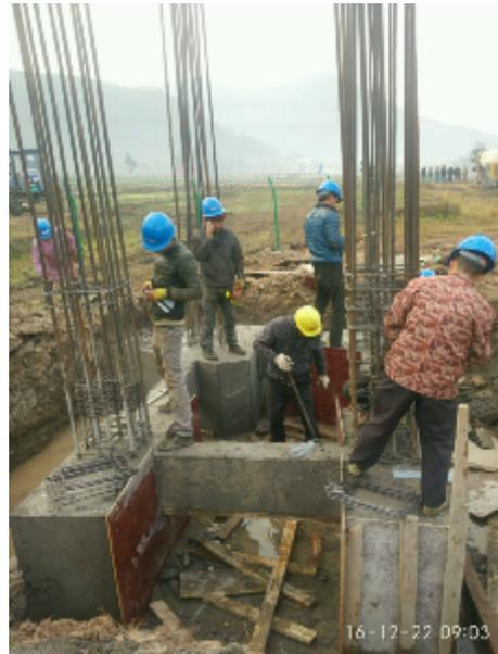
箱变设备基础浇筑及拆模，箱变基础共计 12 基，目前浇筑完成 12 个箱变设备基础承台；
