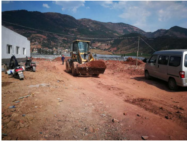
综合楼场地平整
