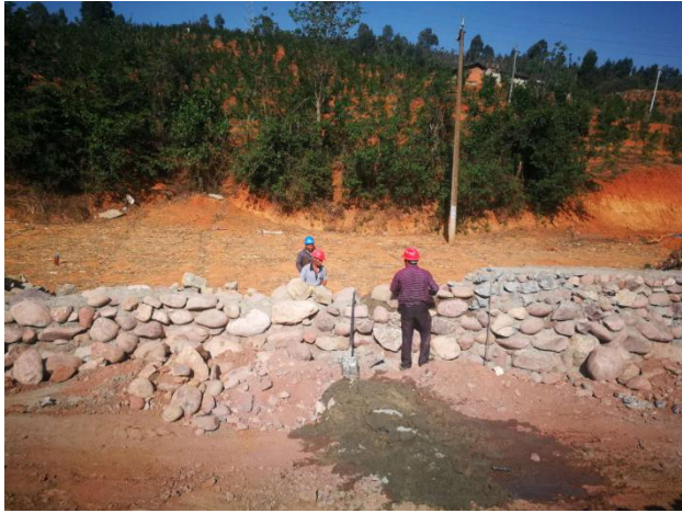
综合楼挡土墙砌筑
