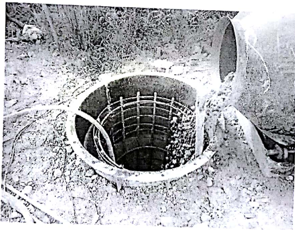
外线塔基孔桩砼浇筑
