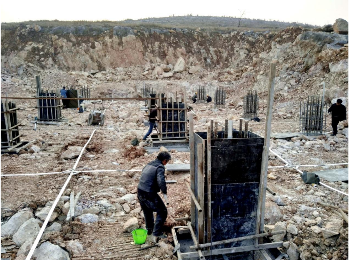
生产楼立柱支模
