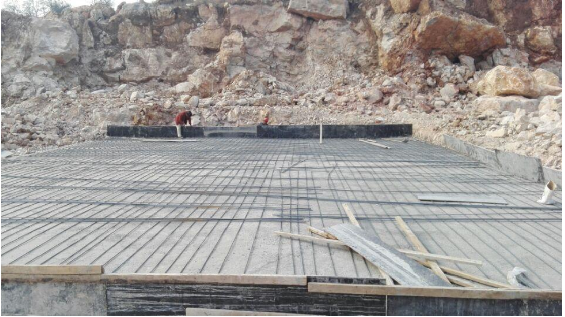
综合楼浅板钢筋绑扎
