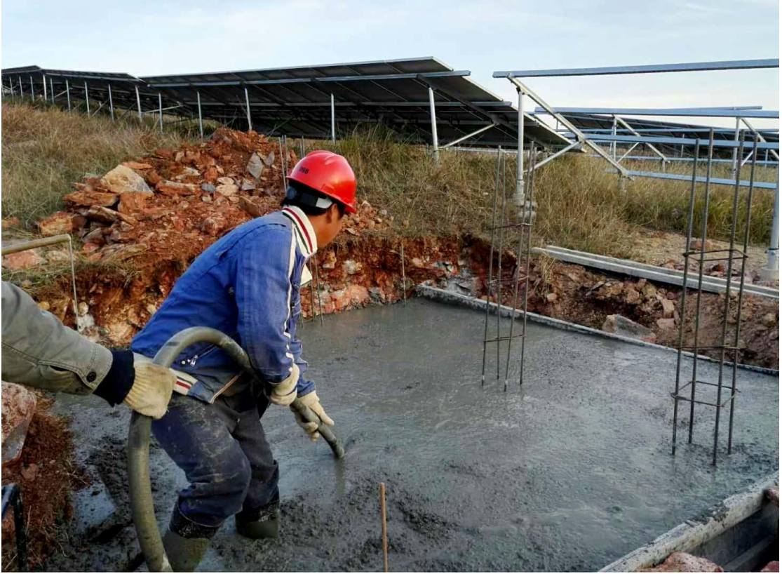
箱变基础浅板捣振
