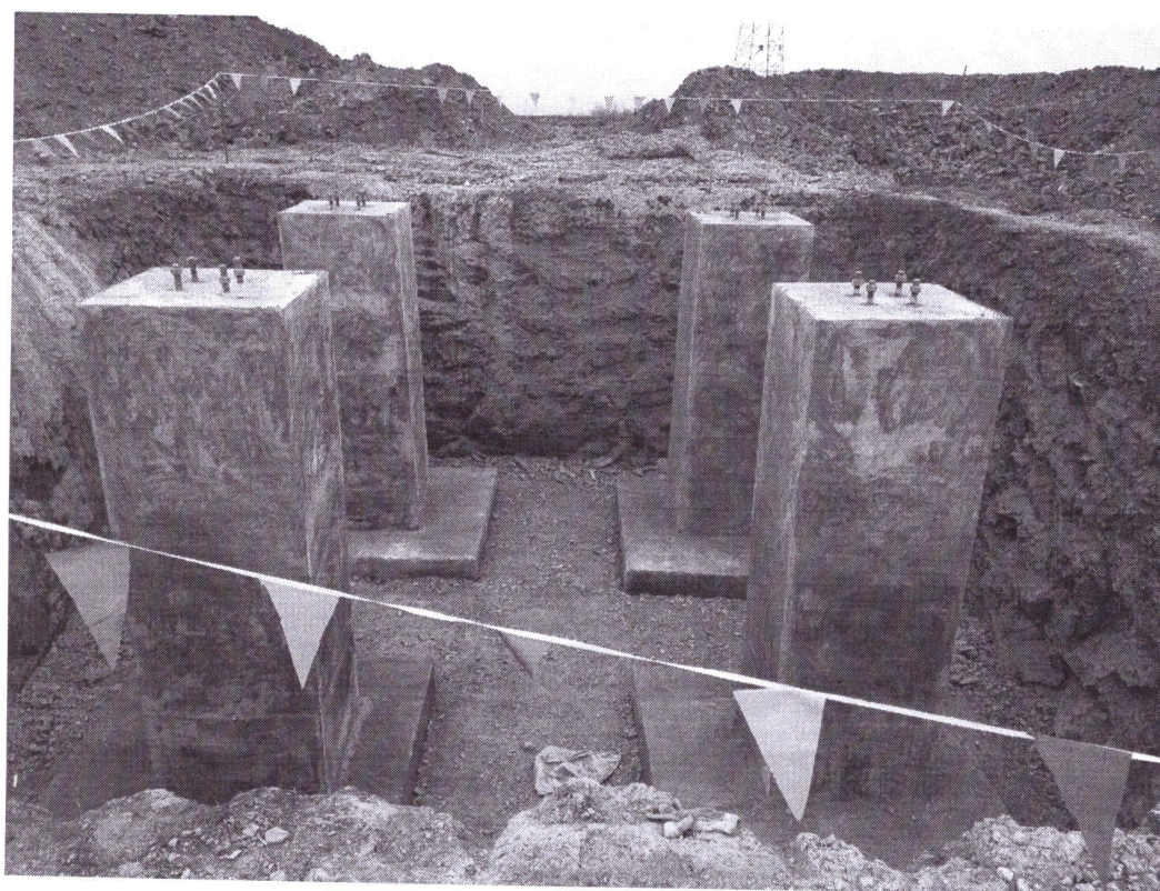
外线铁塔 4#浇筑完成
