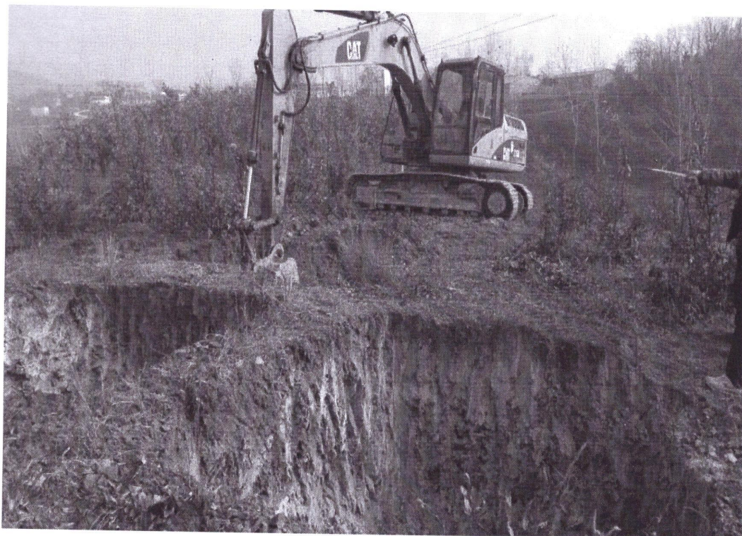
外线铁塔基础开挖
