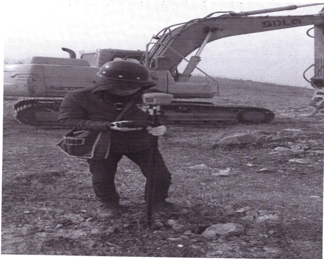
光伏区 GPS 放点
