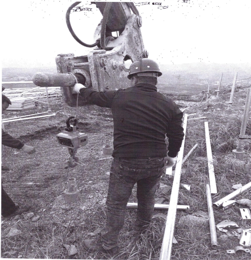
对桩基进行拉拔试验
