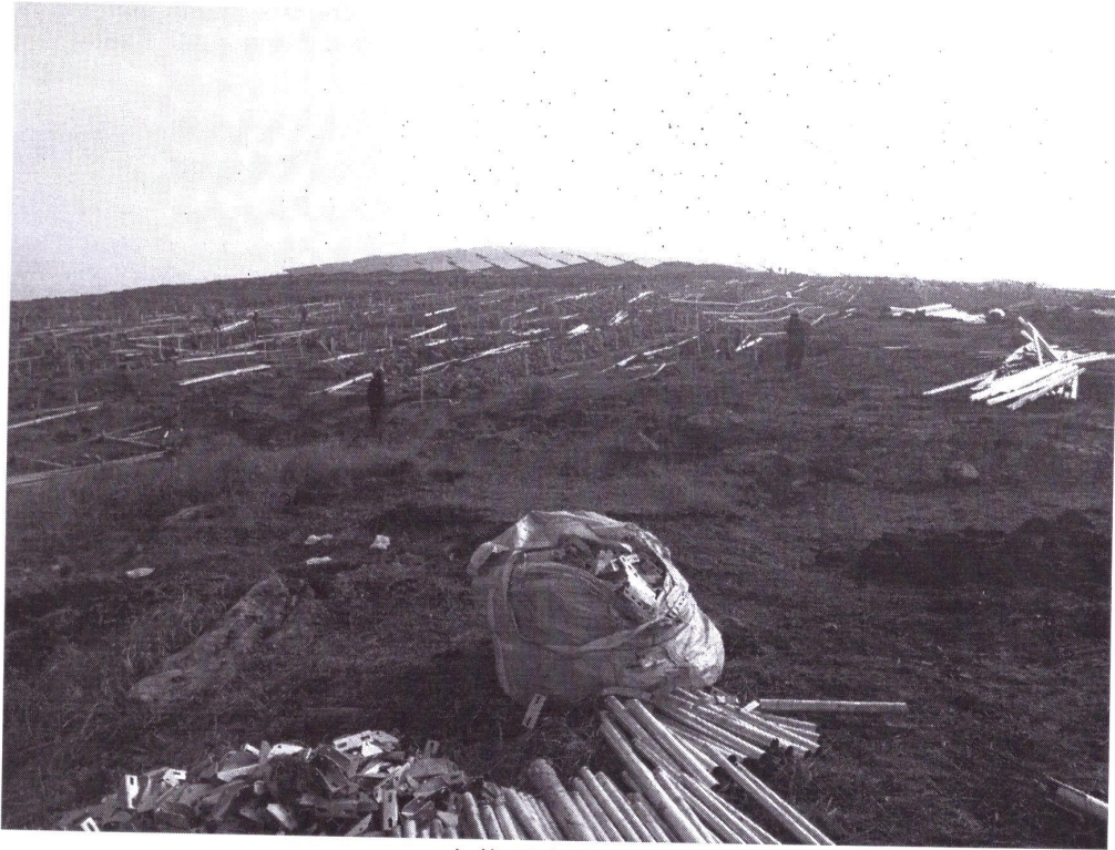
光伏区支架安装
