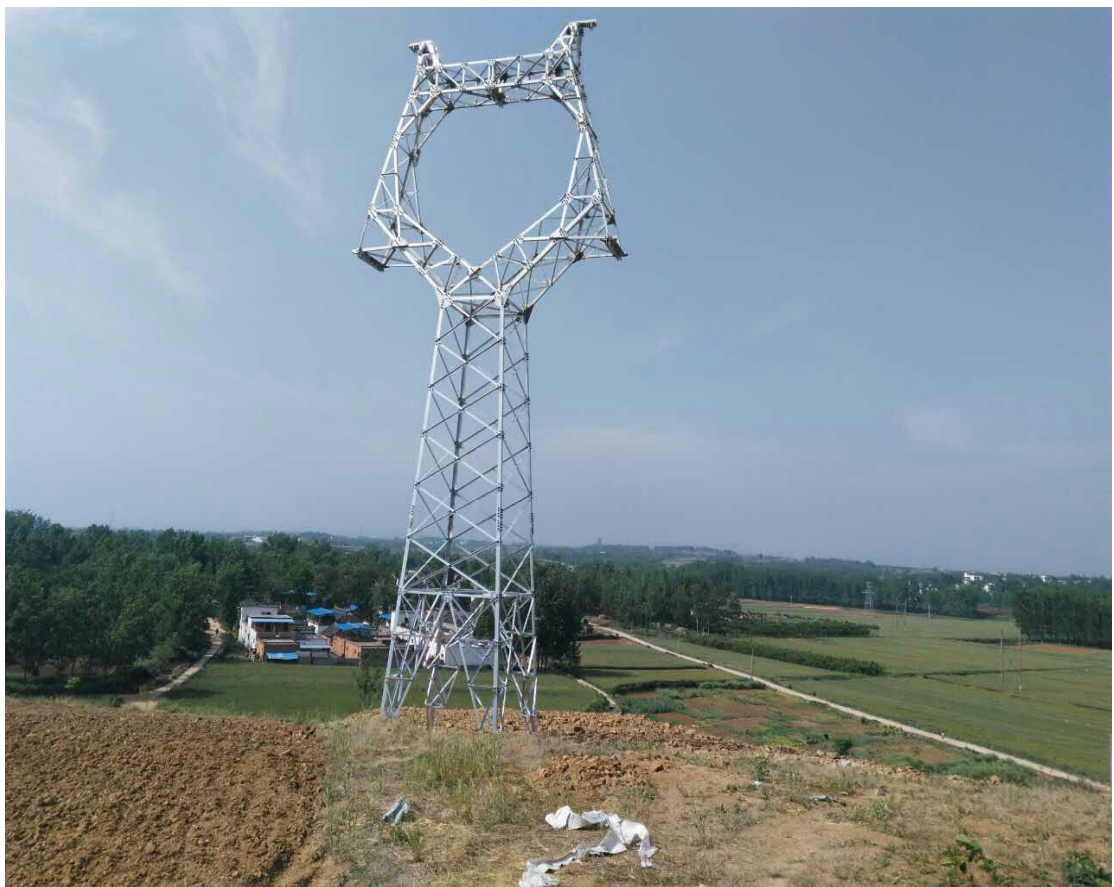
外线 13#铁塔组立完成
