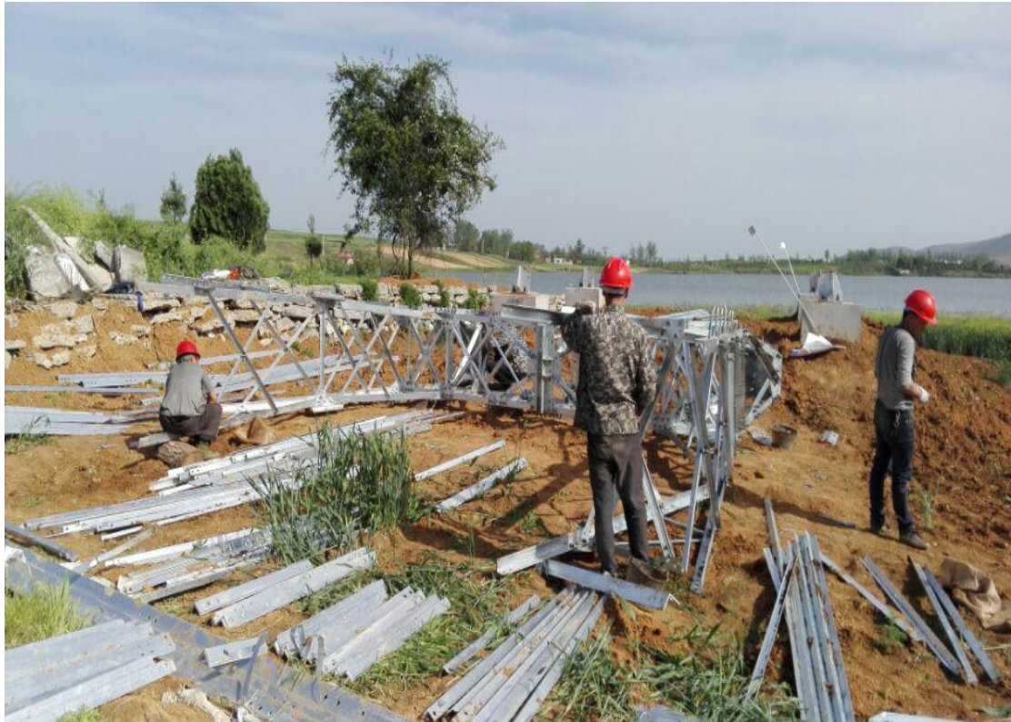
外线铁塔组立
