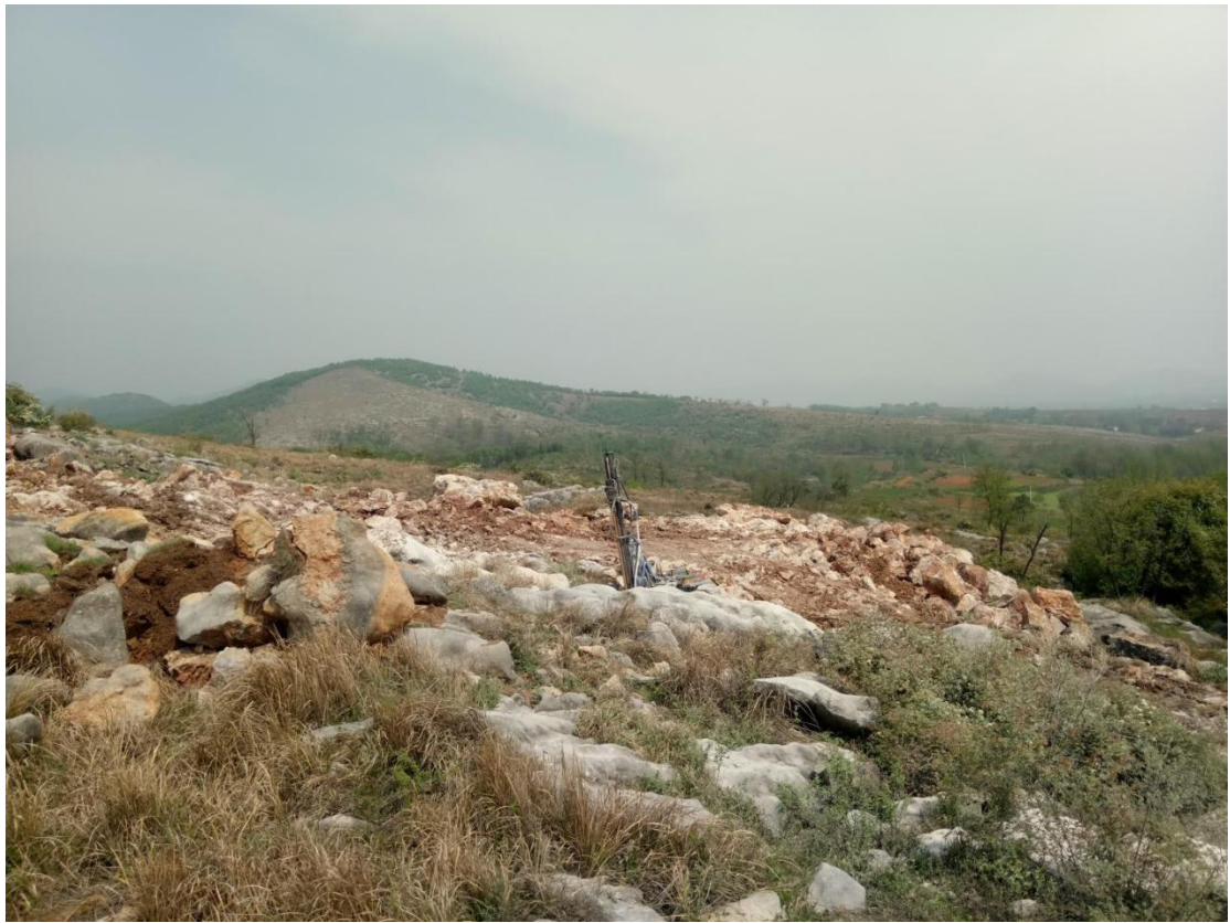
升压站基础爆破
