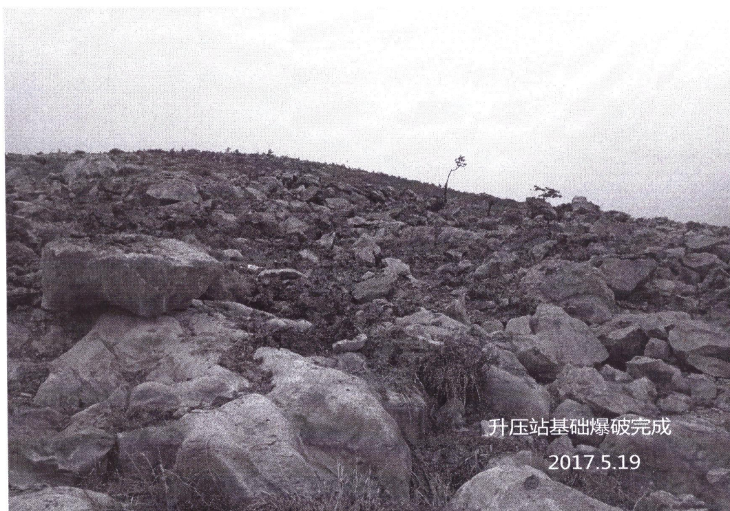
升压站基础爆破完成
