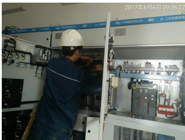
寺上升压站电 气设备安装及 试验;
