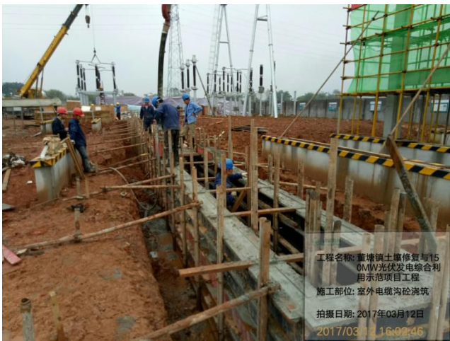
20170312 电缆沟砼浇筑
