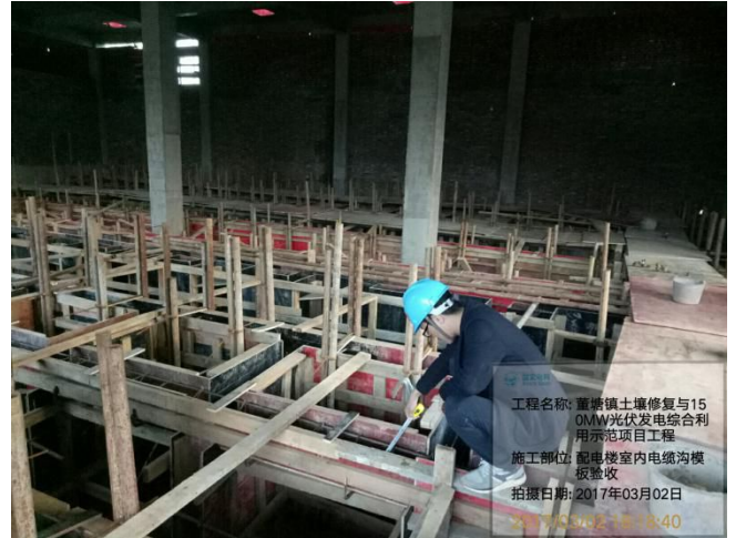
20170302 配电楼室内电缆沟模板验收
