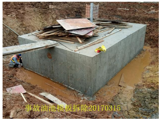
20170315 事故油池模板拆除检查
