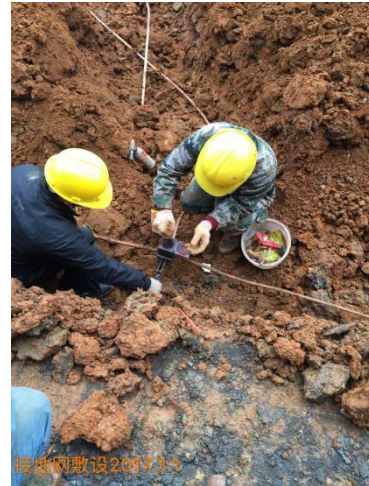
20170301 接地网接头焊接检查
