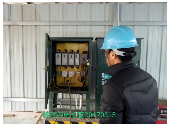
20170315 施工临时用电检查
