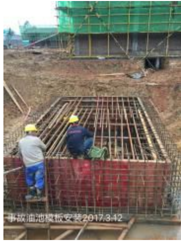
20170312 事故油池钢筋模板
