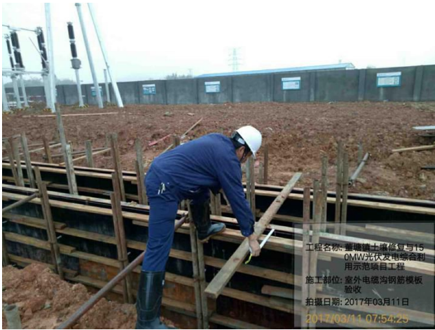
20170311 电缆沟模板验收
