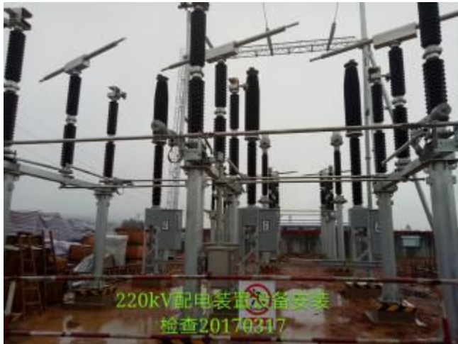
220kV 配电装置区设备安装检查 20170317
