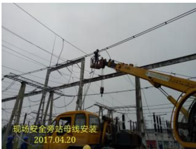
董塘镇 220kV 站母线压接现场安全旁站
