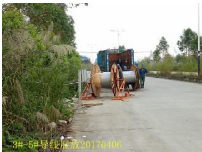
导线展放现场巡视
