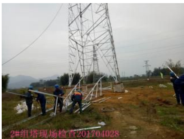
组塔现场安全质量巡视
