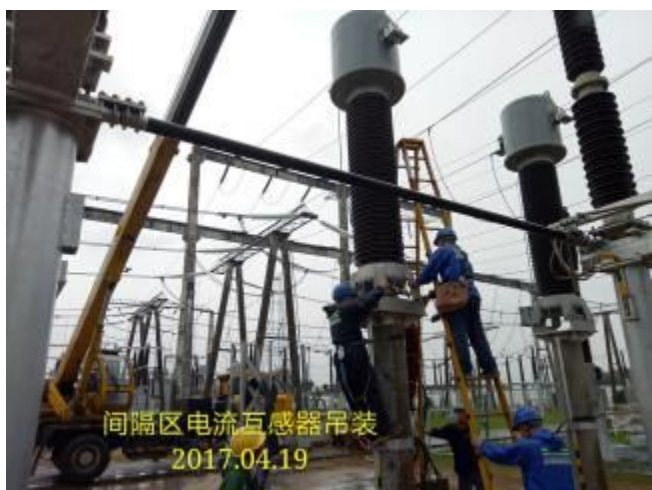
董塘镇 220kV 站间隔区设备吊装旁站
