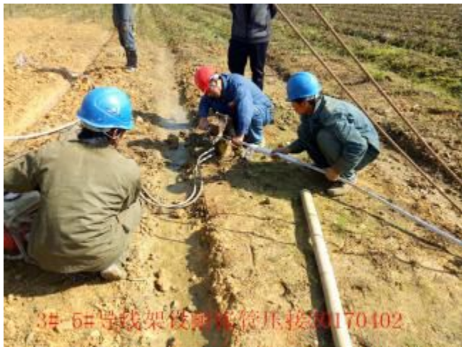
耐张管压接现场旁站
