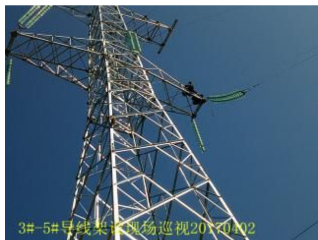
导线架设现场安全质量巡视
