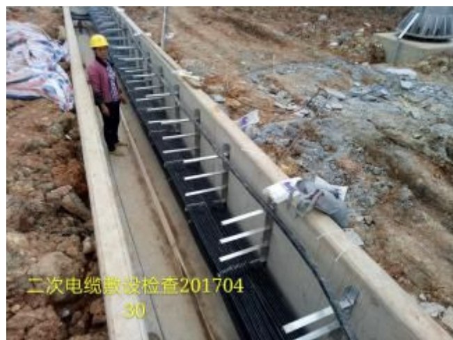
二次电缆敷设检查 20170430
