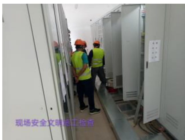
安全文明施工检查
