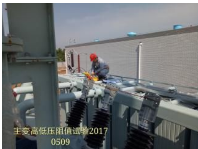
主变高低压阻值测试
