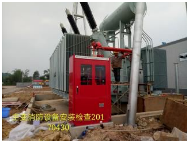
主变消防设备安装 201700430
