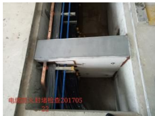
电缆沟防火封堵检查 20170522
