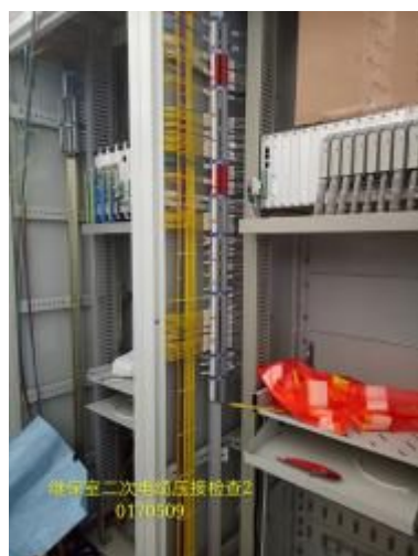
二次电缆压接检查
