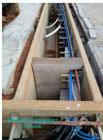
电缆沟防火封堵隐蔽验收 20170608
