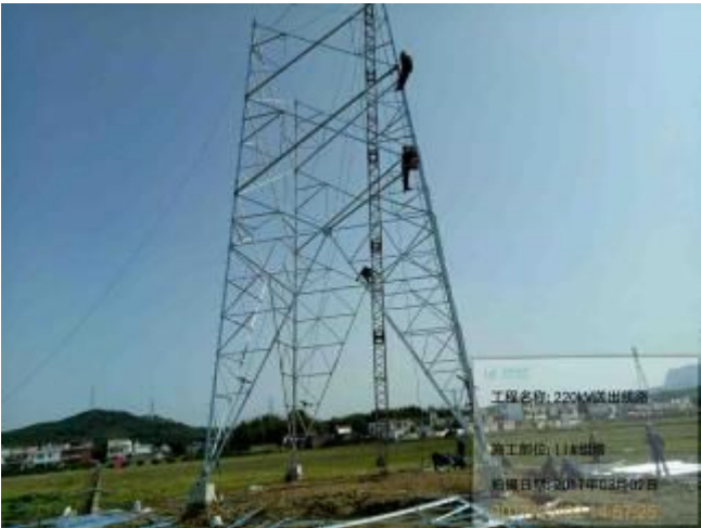
20170302 #11 组塔现场检查
