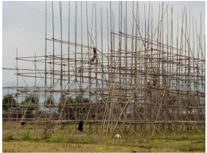
20170306 跨越架搭设检查
