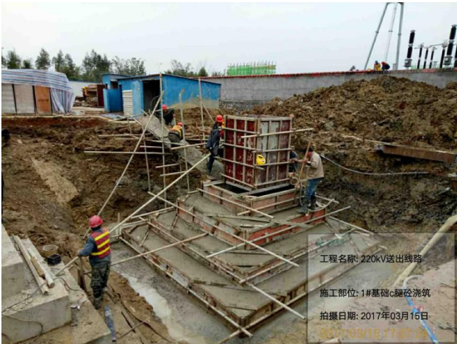
20170316 #1 塔基础浇筑
