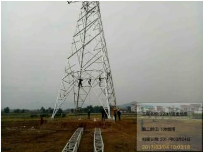
20170304 #10 组塔现场检查
