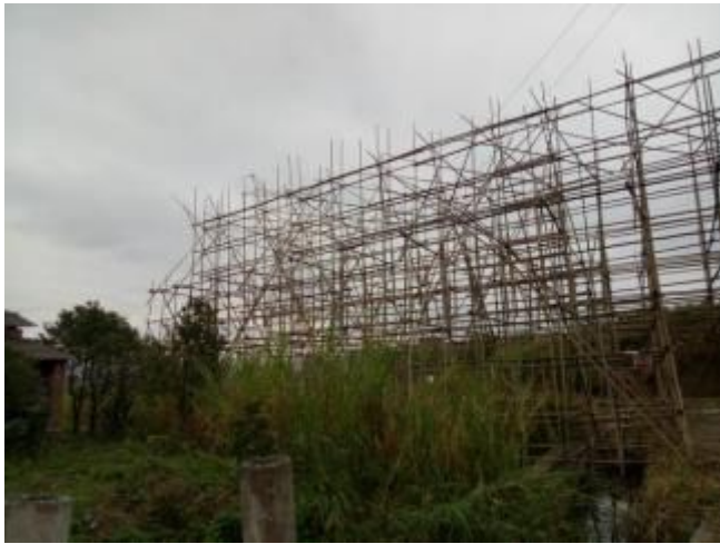
20170310 跨越架搭设检查
