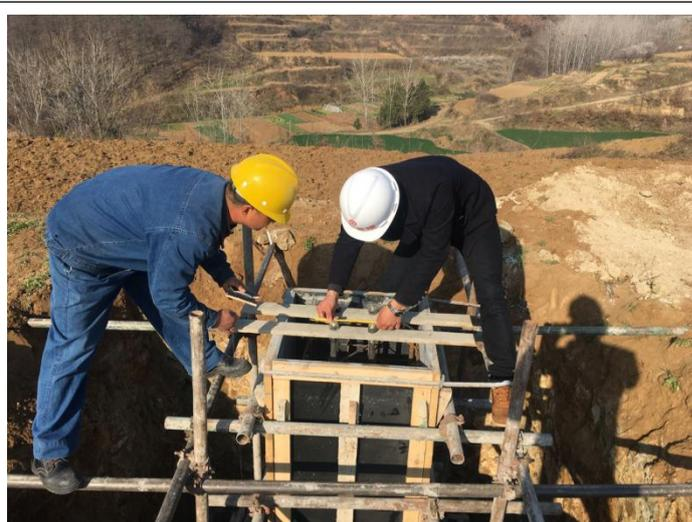
外线铁塔基础 T11 基础钢筋模板，预埋螺栓验收
