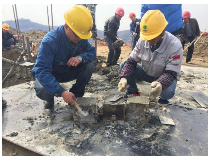
外线铁塔基础 T12 基础混凝土试块现场制作
