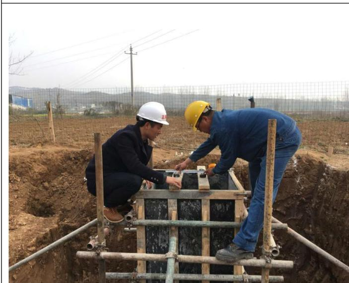
外线铁塔基础 T15 基础预埋螺栓根开验收
