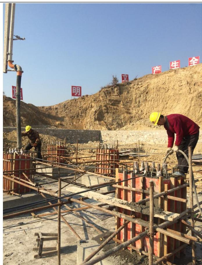
110kV 升压站电气楼基础承台混凝土浇筑
