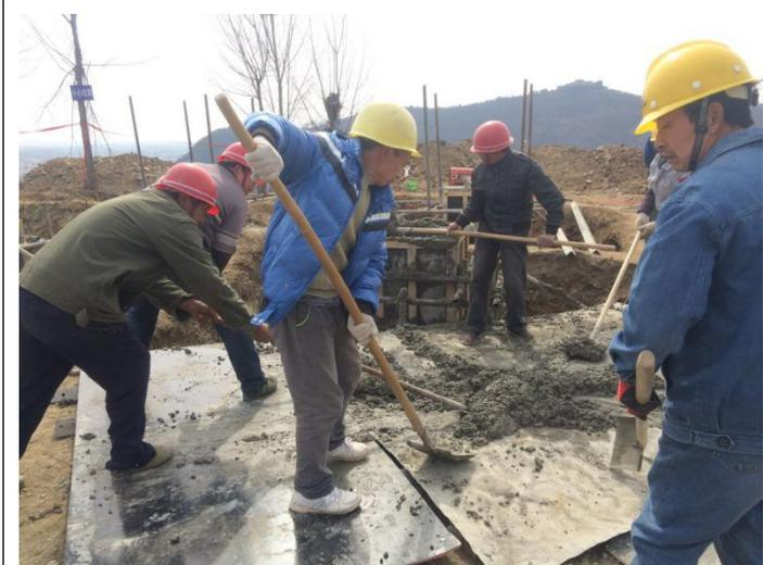
外线铁塔基础 T12 基础混凝土浇筑
