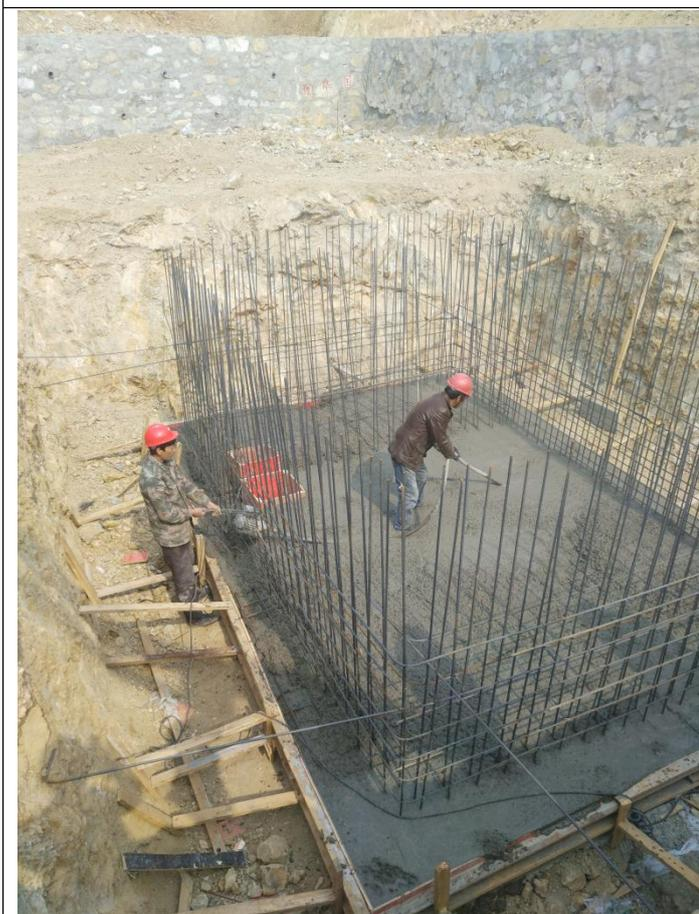
110kV 升压站事故油池底板混凝土浇筑
