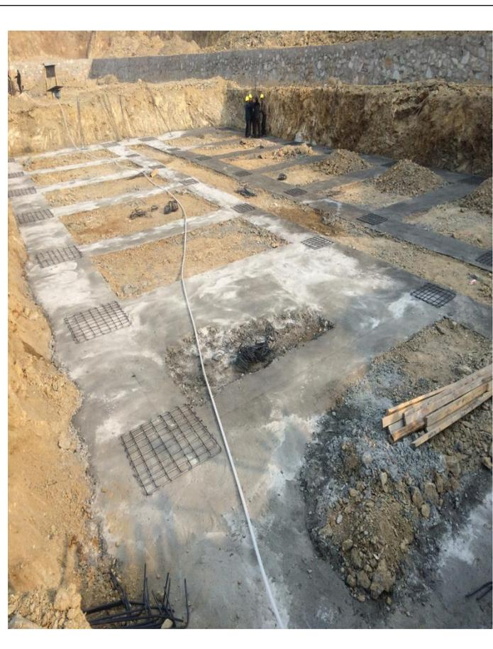
110kV 升压站办公综合楼基础垫层混凝土浇筑
