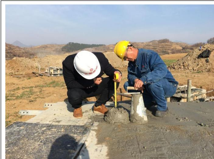
外线铁塔基础 T11 基础混凝土坍落度检查
