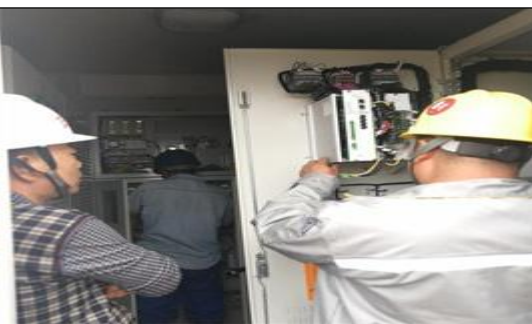
光伏东区17-21号方阵箱逆变设备倒送电
