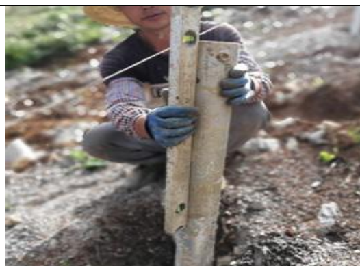
光伏东区17号方阵混凝土灌注桩施工
