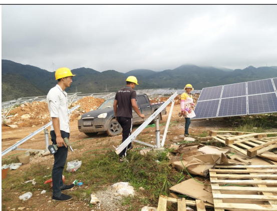
光伏东区17号方阵支架组件安装
