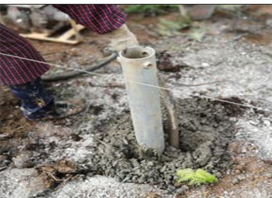
光伏东区17号方阵混凝土灌注桩施工
