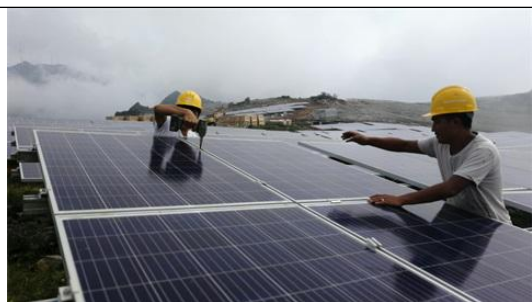
光伏东区17号、18号方阵支架组件安装
