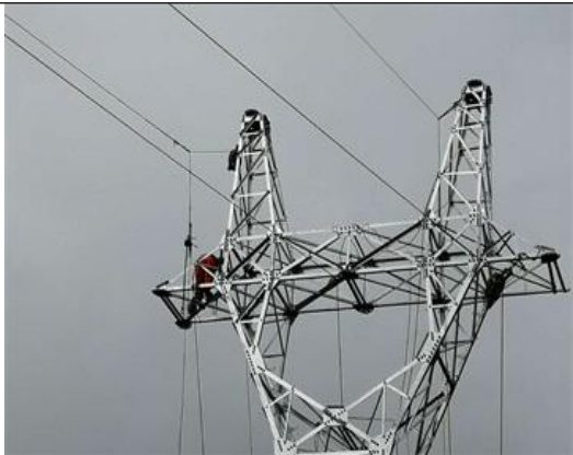
光伏东区集电线路铁塔架线
