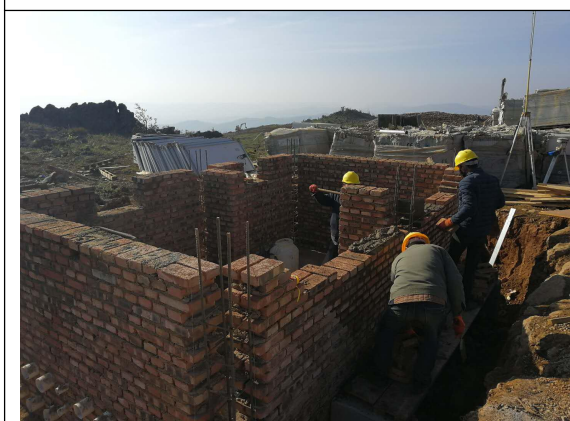
光伏东区19号方阵箱逆变设备基础砖砌 体砌筑
