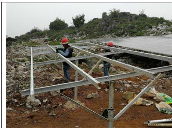
光伏东区17#、19#方阵支架安装
