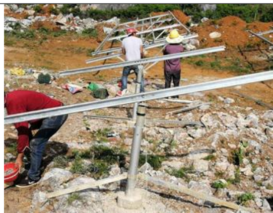
光伏东区17#、19#方阵支架安装
