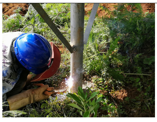
光伏东区21号方阵支架接地扁铁焊接
