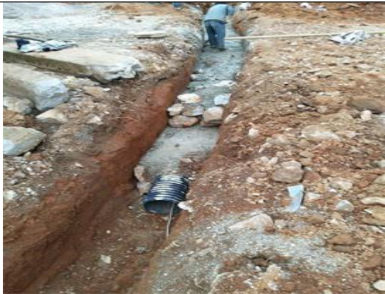
光伏东区集电线路电缆沟过道电缆保护管预埋
