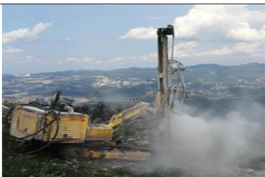
光伏东区17号方阵桩机钻孔施工
