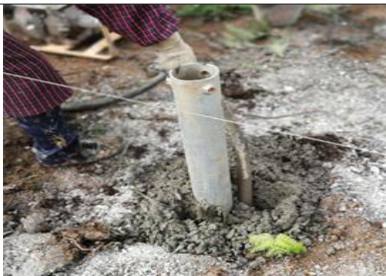
光伏东区21号方阵混凝土灌注桩施工
