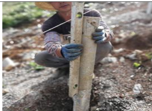
光伏东区21号方阵混凝土灌注桩施工
