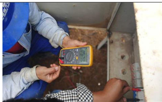
光伏东区17号方阵箱逆变设备倒送电
