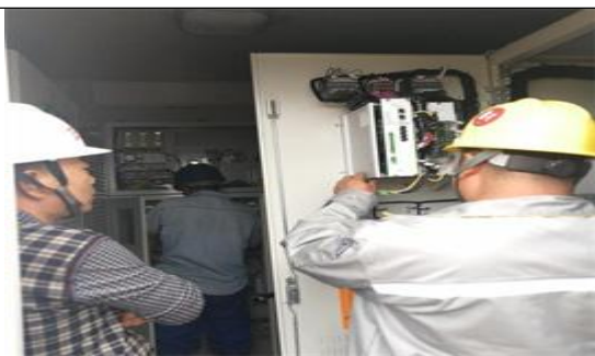
光伏东区17号方阵箱逆变设备倒送电
