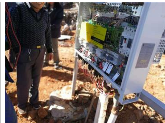
光伏东区20号方阵电缆标识牌安装
