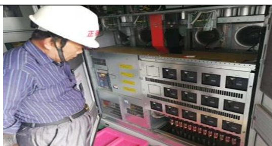
光伏东区18号方阵箱逆变设备直流侧 电缆接线
