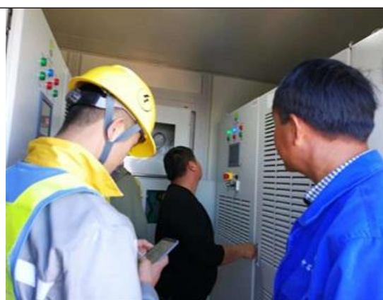
光伏区21、20号方阵箱逆变设备调试
