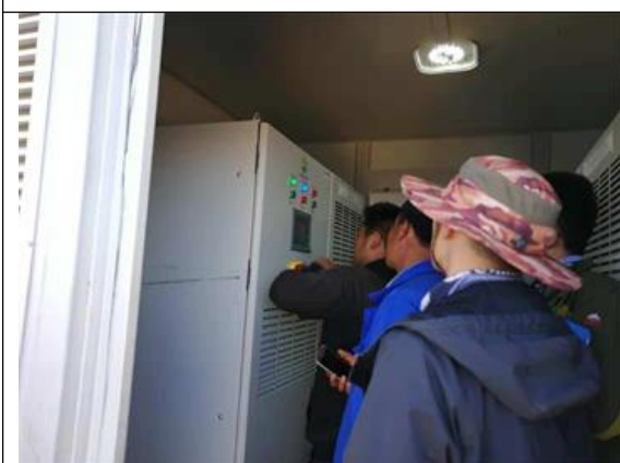
光伏区21、20号方阵箱逆变设备调试
