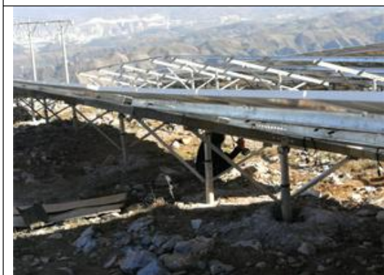
光伏东区17号方阵组件安装
