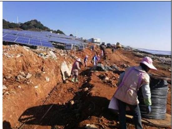
光伏东区20号方阵汇流箱至箱变处通讯电缆敷设
