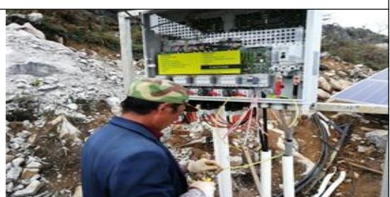
光伏区20号方阵汇流箱电缆接线以及接
