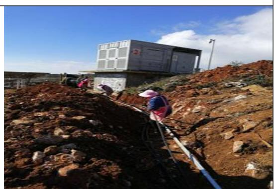
光伏东区21号方阵汇流箱至箱变处直流电缆敷设
