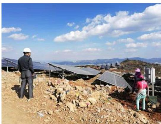
光伏东区18号方阵支架至汇流箱4m m<sup>2</sup>直流电缆接线
