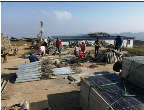
16号方阵后补1MW支架材料准备
