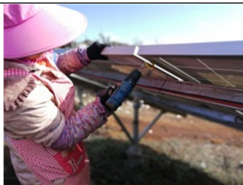
16号方阵后补1MW支架安装
