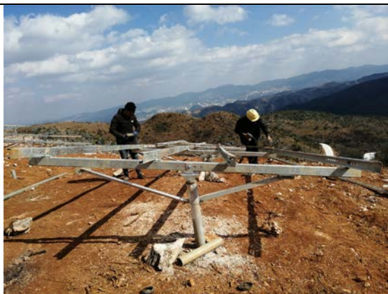
16号方阵后补1MW支架安装
