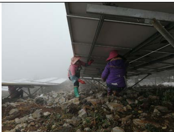
光伏东区21号方阵支架螺栓紧固
