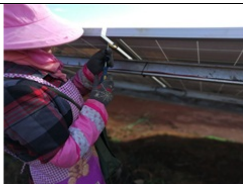
光伏东区17号方阵组件跨接线安装
