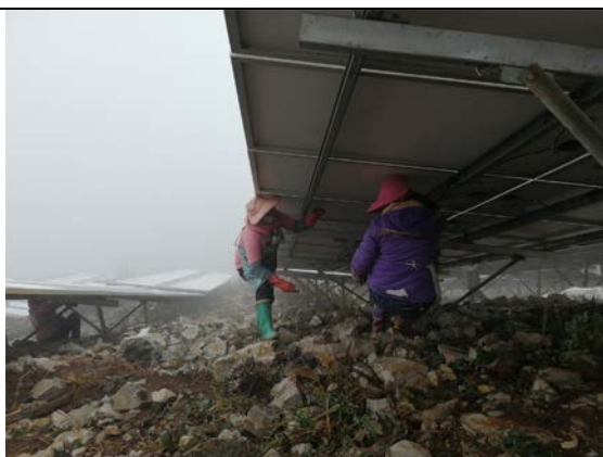
光伏东区21号方阵支架螺栓紧固
