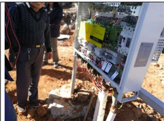
光伏东区20号方阵电缆标识牌安装
