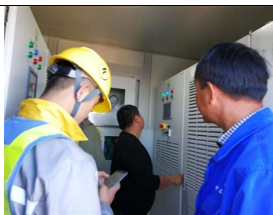
光伏区21、20号方阵箱逆变设备调试
