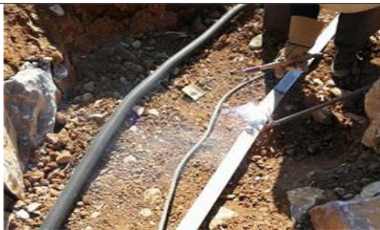
光伏东区18号方阵场区接地扁铁焊接
