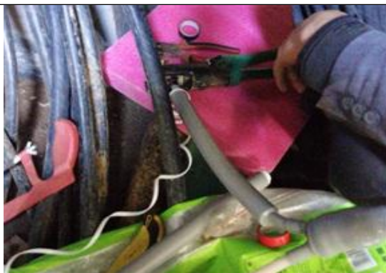
光伏东区19号方阵箱逆变器直流侧电缆接线
