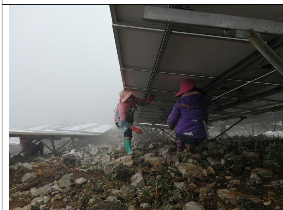
光伏区20号方阵支架螺栓紧固
