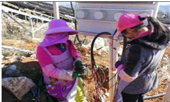
光伏东区18号方阵支架至汇流箱处4m 2 直流电缆接线
