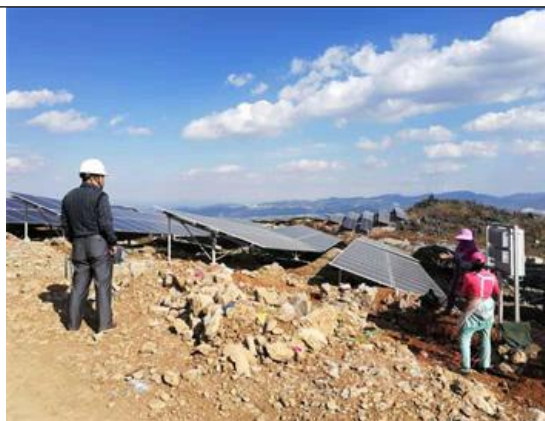
光伏东区18号方阵支架至汇流箱4m 2 直流电缆接线
