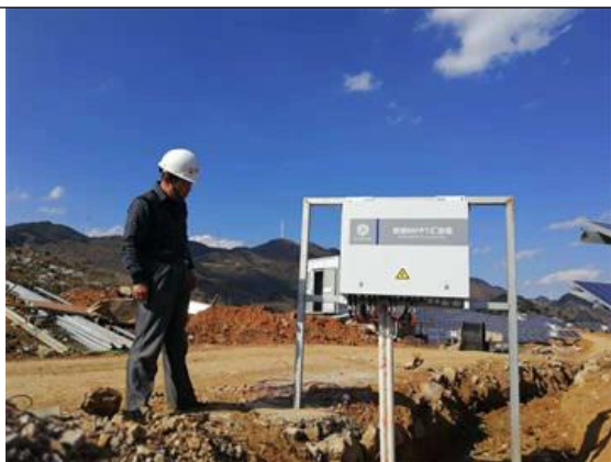
光伏东区18号方阵支架至汇流箱4m 2 直流电缆接线
