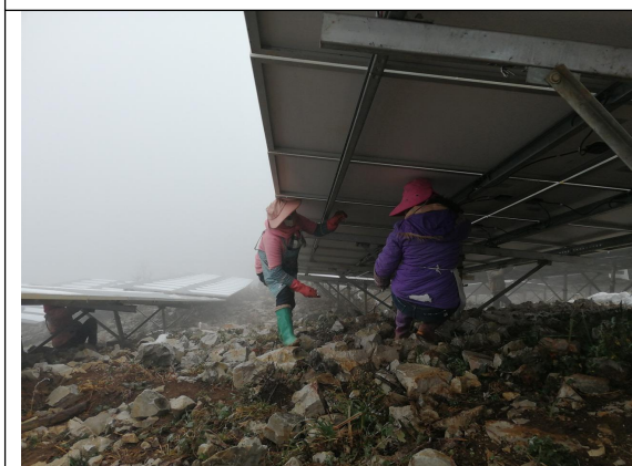
光伏东区21号方阵支架螺栓紧固
