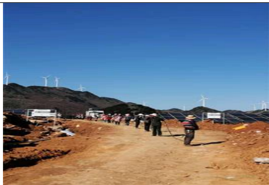
光伏东区19号方阵汇流箱至箱变处直流电缆敷设
