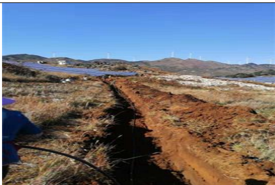
光伏东区19号方阵汇流箱至箱变处直流电缆敷设
