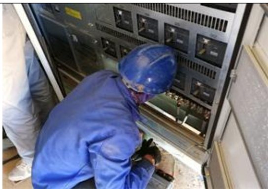
光伏东区19号方阵箱逆变器直流侧电缆接线
