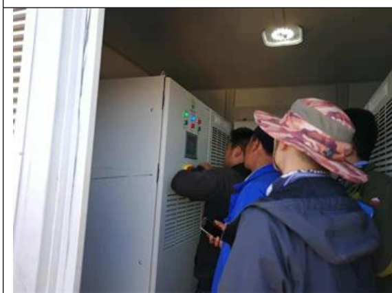
光伏区21、20号方阵箱逆变设备调试
