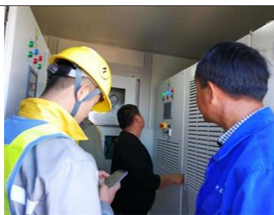
光伏区21、20号方阵箱逆变设备调试
