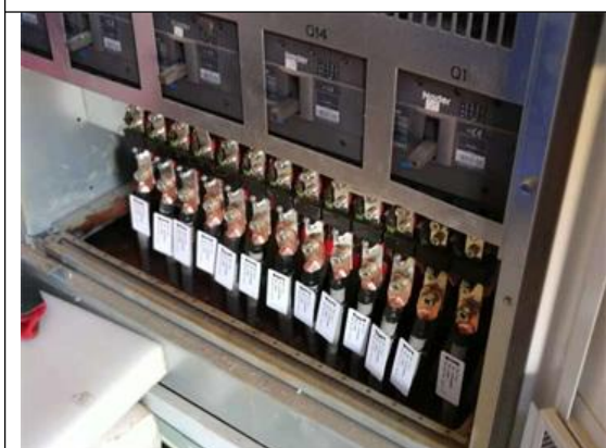
光伏东区19号方阵箱逆变器直流侧电 缆铭牌安装
