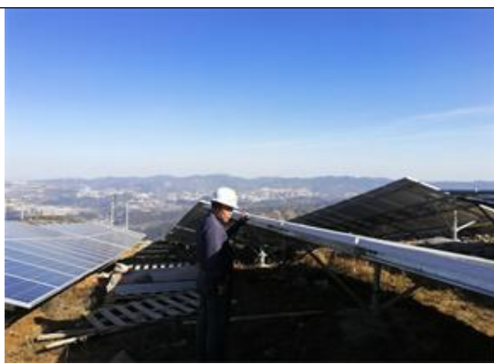
巡查光伏东区17号方阵组件安装质量 情况
