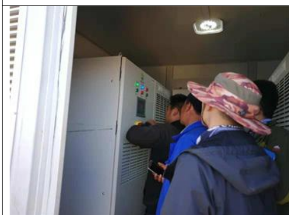
光伏区21、20号方阵箱逆变设备调试
