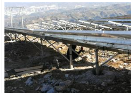
光伏东区17号方阵组件安装
