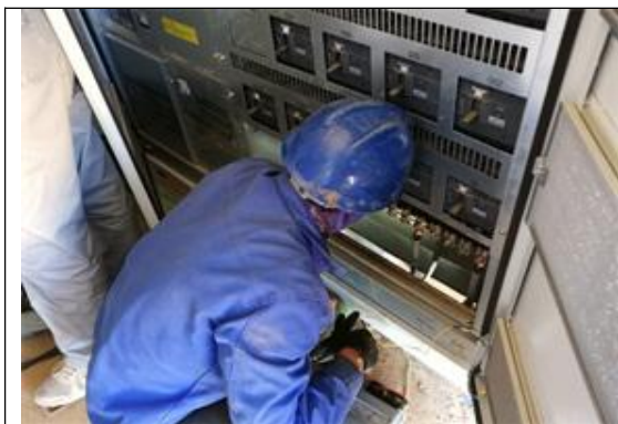
光伏东区19号方阵箱逆变器直流侧电缆接线
