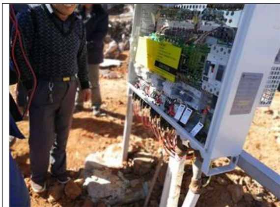
光伏东区20号方阵电缆标识牌安装
