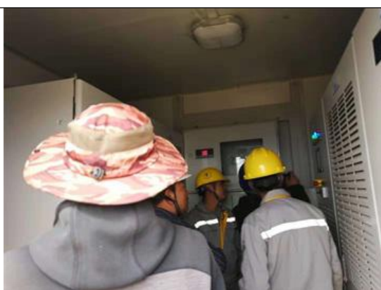
光伏东区19号方阵箱逆变设备调试
