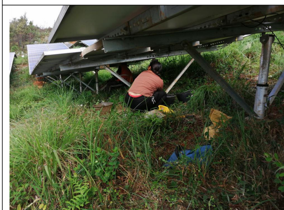
光伏区支架生锈螺栓更换
