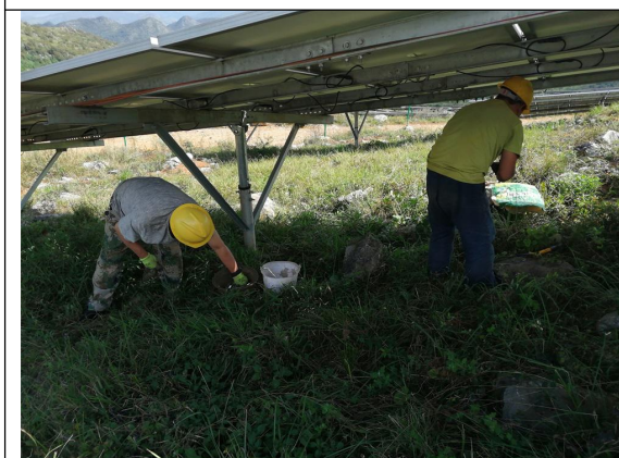
光伏区支架生锈螺栓更换
