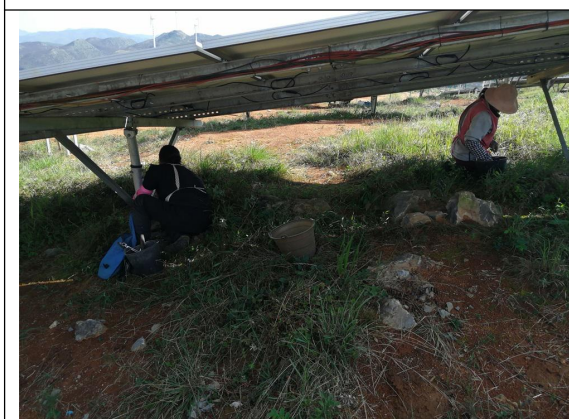
光伏区支架生锈螺栓更换
