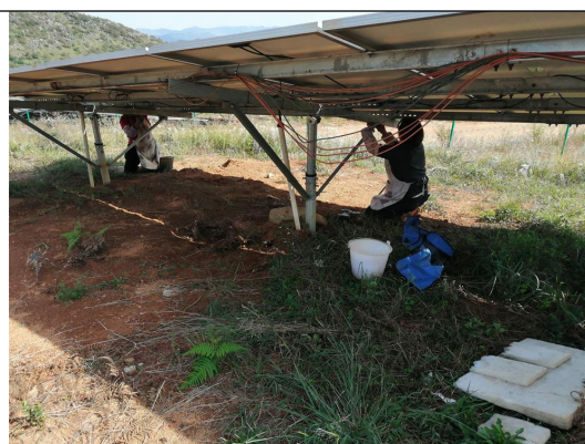
光伏区支架生锈螺栓更换
