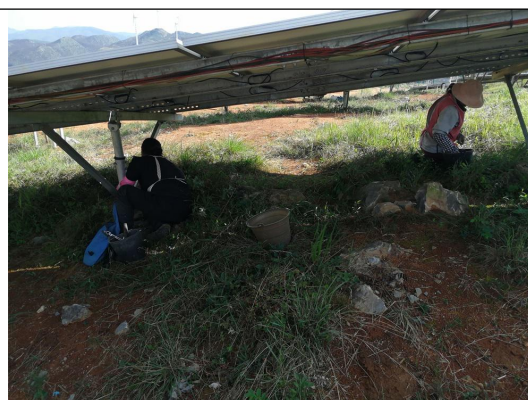
光伏区支架生锈螺栓更换
