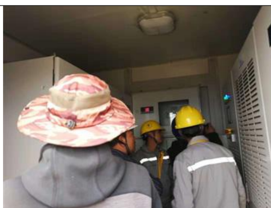
光伏东区19号方阵箱逆变设备调试
