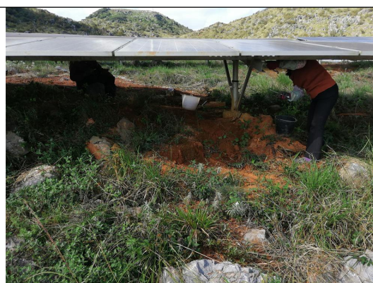
光伏区支架生锈螺栓更换
