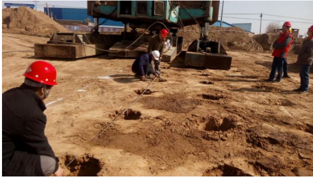
监理对挤密桩的中心距复测。
