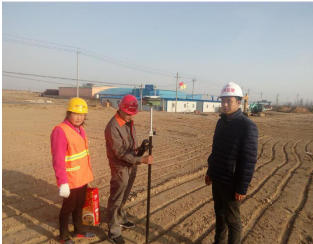
2017、2、24 日管桩定点测量
