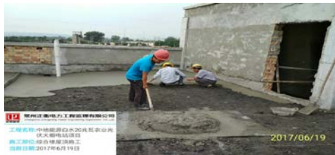
综合楼屋面砂浆找平
