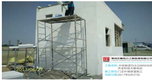
门卫外墙保温施工
