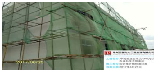
综合楼外墙保温施工
