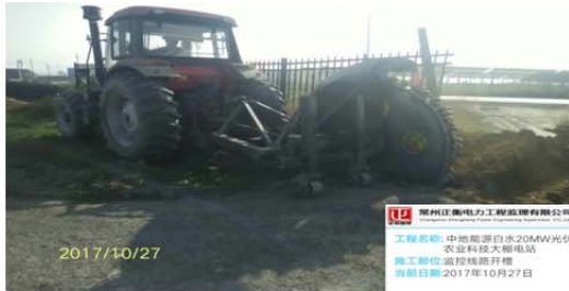
监控线路开槽
